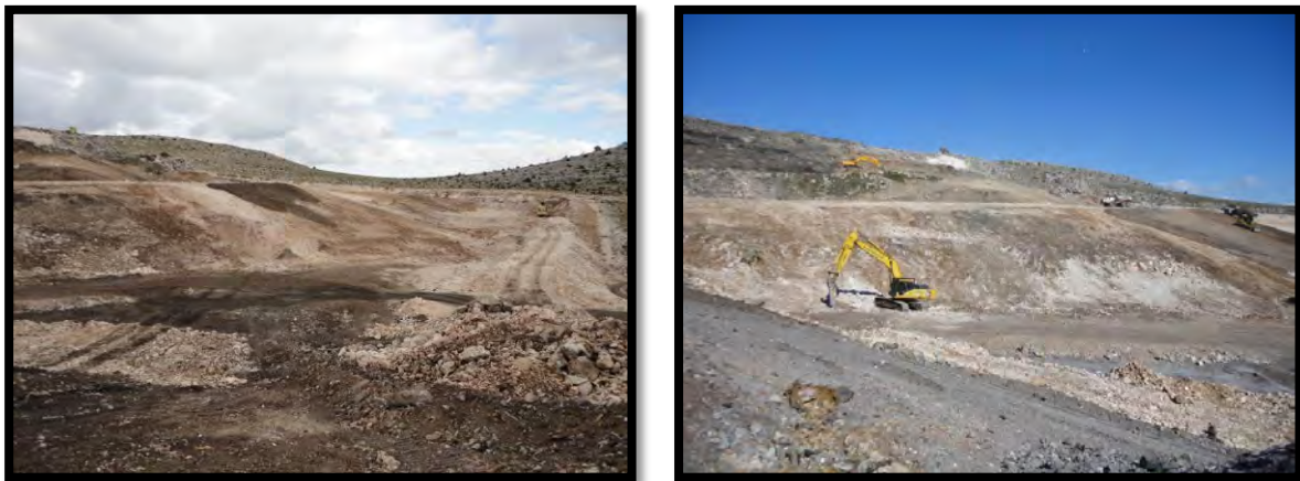
Slika 4.1.1-1. Iskop za potrebe uređenja odlagališne plohe 1 – tlo A kategorije
